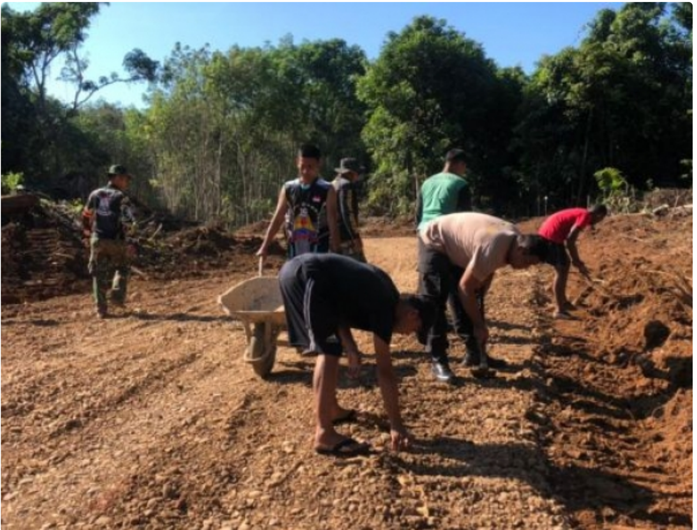
TMMD Ke-113 Kodim 1006/Banjar Kebut Selesaikan Sasaran Fisik (Jalan)
