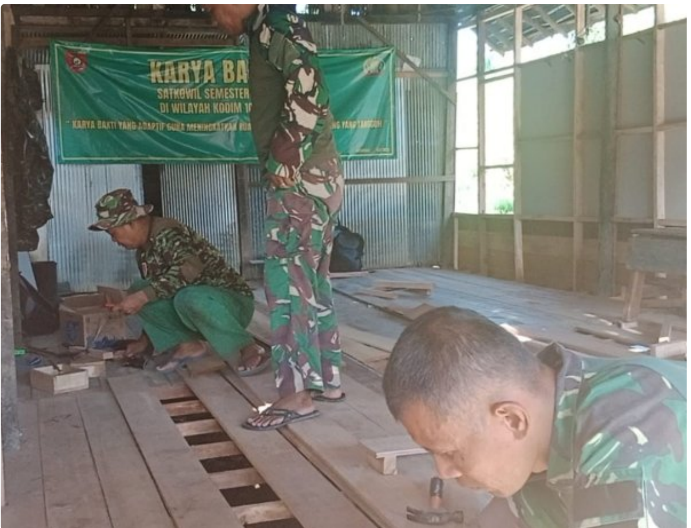
Rehab Rumah RTLH Karya Bakti TNI Kodim 1006/Banjar Hampir Rampung Pengerjaannya
