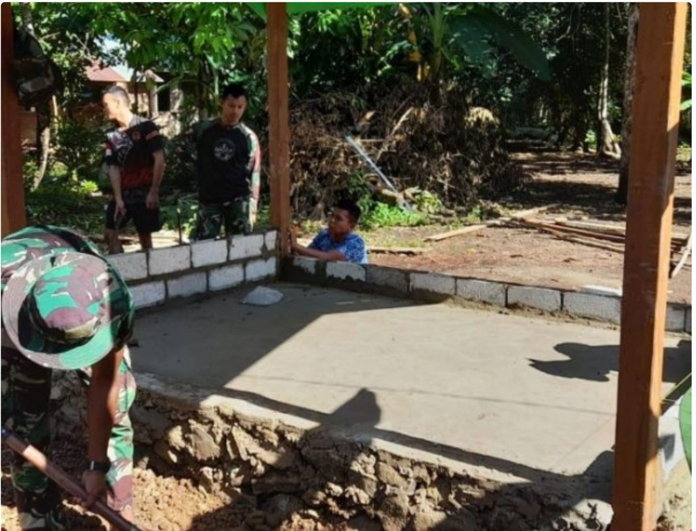
Satgas TMMD ke-113 Kodim 1006/Banjar Pasang Dinding dan Lantai Poskamling
