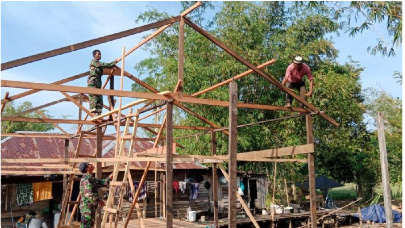
Karya Bakti TNI " Kodim 1006/Bjr Rehab Rumah Kini Sudah Pemasangan Lantai Dan Kuda - Kuda
