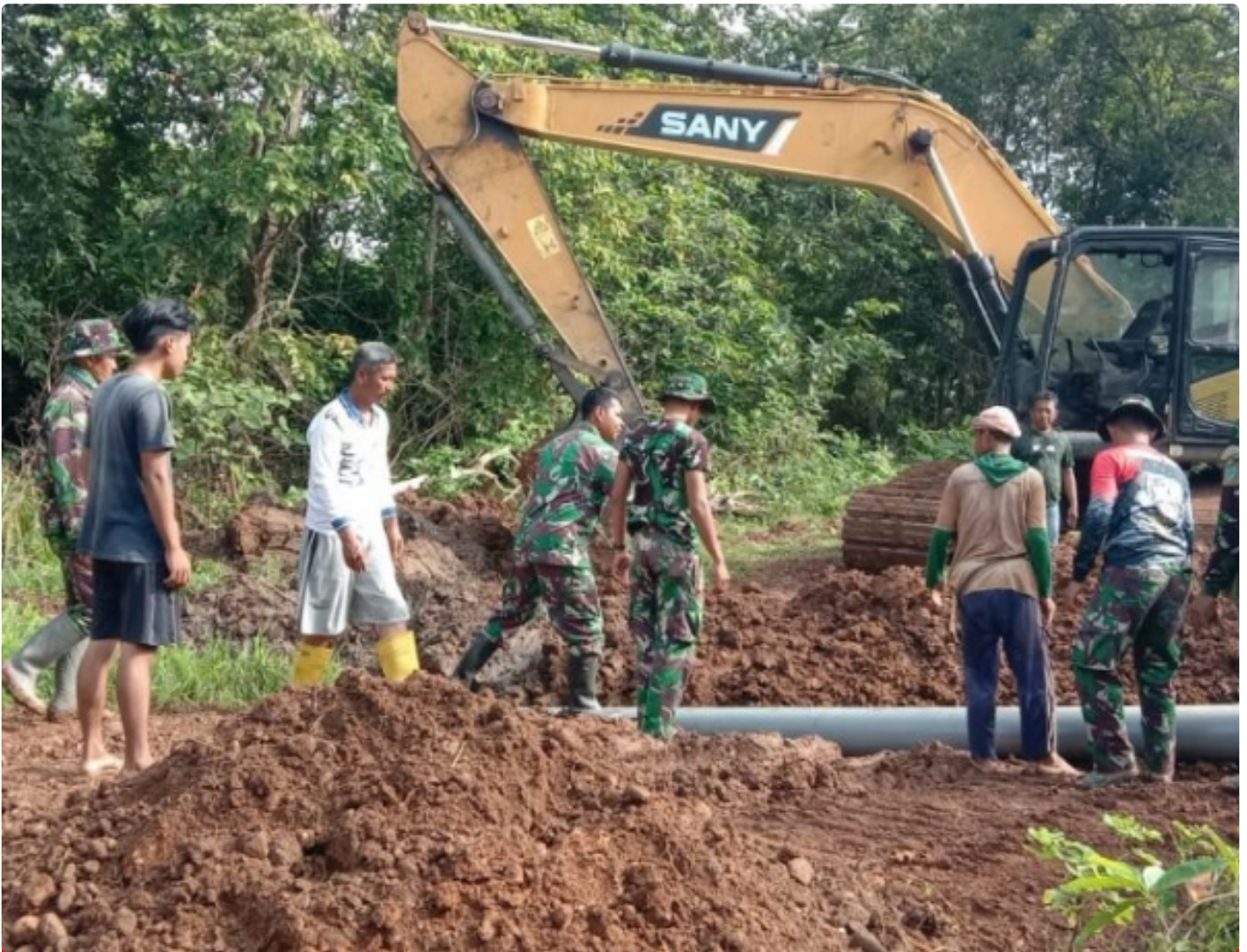
Pemasangan Pipa Saluran Air
